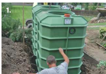
Versetzen PE Behälter
