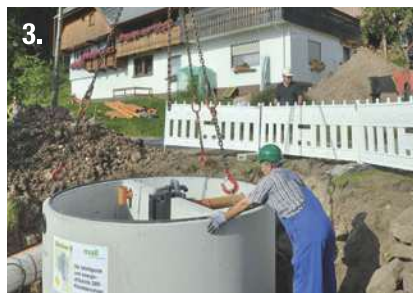
Behälter versetzen
