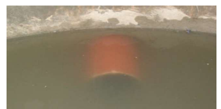
Wasserspiegel bei der Prüfung 50 mm über dem obersten Rohrscheitel
