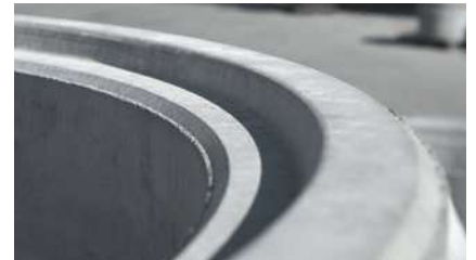
Bauteilverbindung mit Falz und bauseitiger Mörtelfuge
