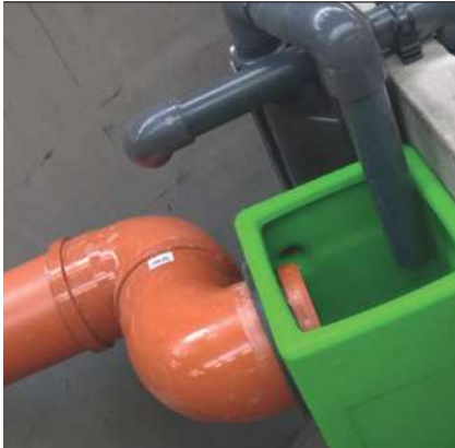
Automatische Schaltzentrale (= das Köpfchen der Anlage mit d-pac®)
