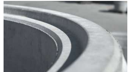
Bauteilverbindung mit Falz und bauseitiger Mörtelfuge
